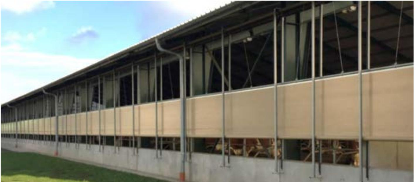
An Stellen, an denen ein erhöhter Luftstrom verhindert werden muss, werden serienmäßig Anti-Zugluft-Systeme installiert. Betriebe nutzen diese Systeme zur Regulierung der Luftströme. Für diese Anforderungen bieten wir Seitenlüftungs Systeme in Rollausführung an, aber auch gefaltet, verschiebbar oder feststehend.
